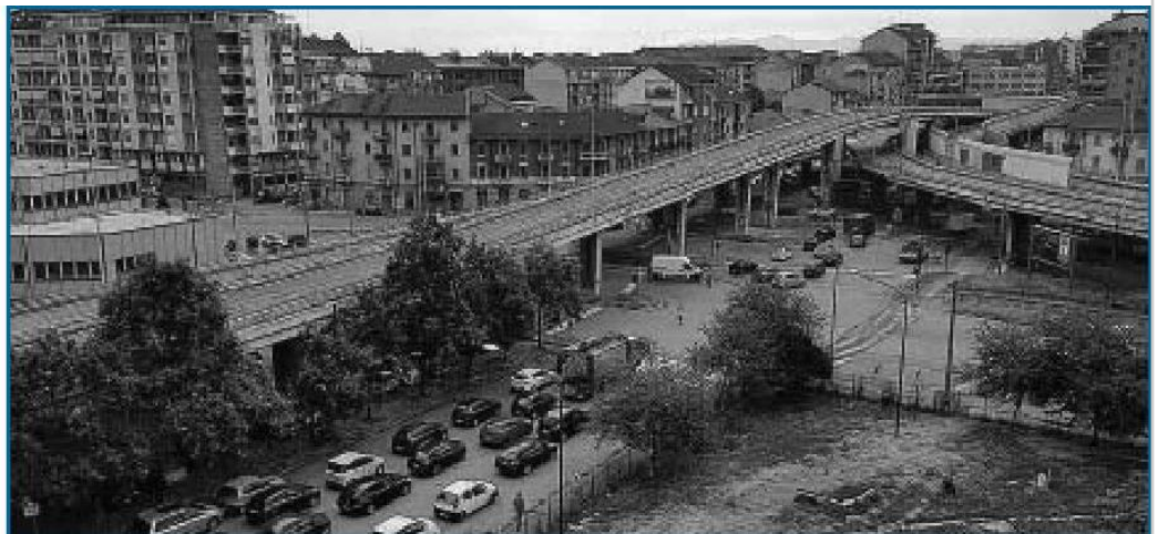
Quasi tre anni di passione per lo scavo del tunnel della Torino-Ceres sotto corso Grosseto
