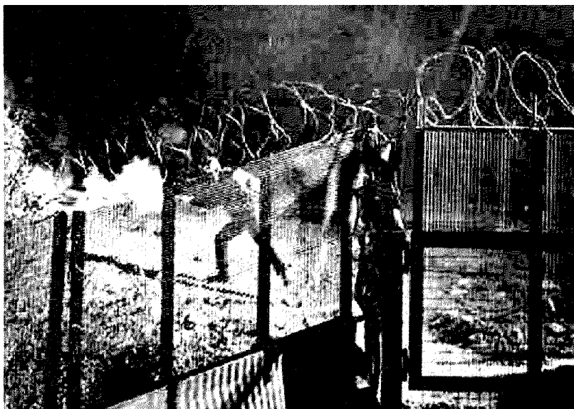
Le recinzioni e il filo spinato a protezione del cantiere Tav di Chiomonte
