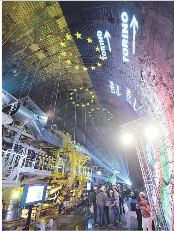
Torino-Lione. Lo scavo sul versante francese a Saint Martin La Porte
