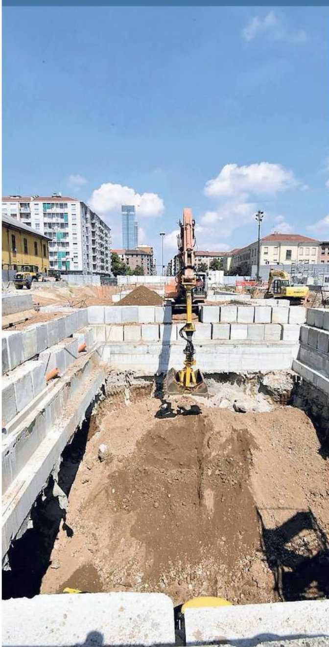
Il cantiere del metrò tra il Lingotto e piazza Bengasi
