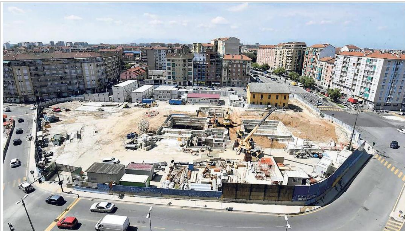
Il cantiere del metrò in piazza Bengasi
